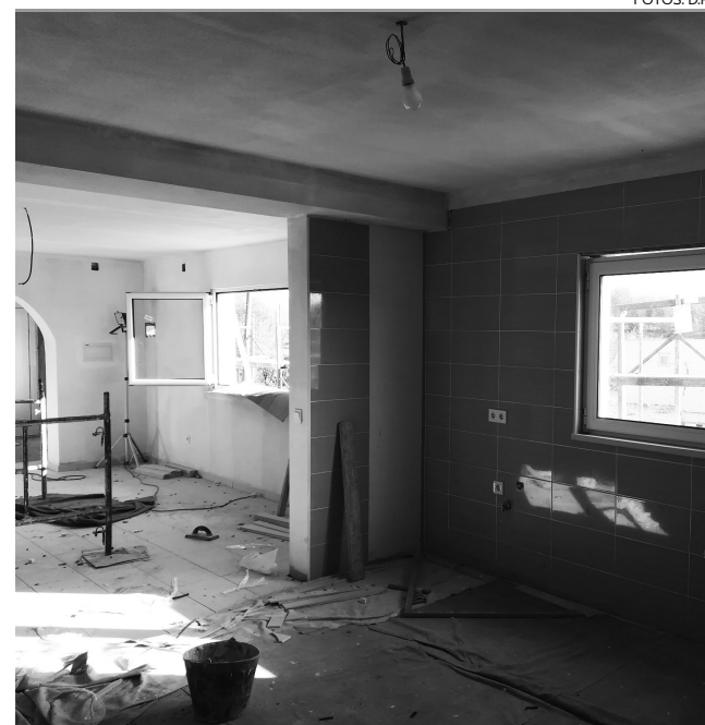
Ainda há bastantes trabalhos até dar a obra por concluída
